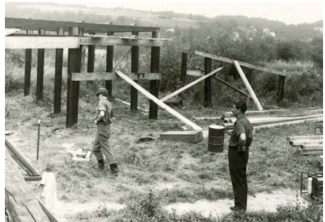
Baustellenbesichtigung durch Obmann Herbert Ellegast
