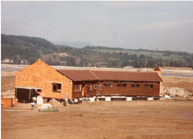
Die Giebelmauer läßt die neue Größe erahnen.
