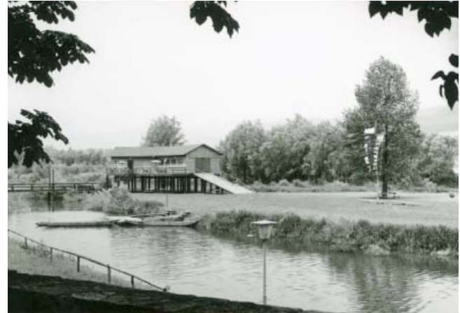
Das fertige Bootshaus 1971
