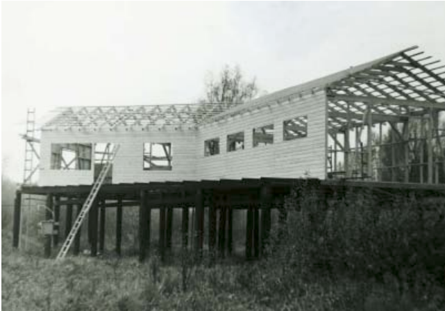
Das Bootshaus nimmt Form an
