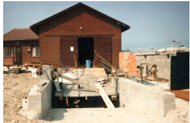
Der Zubau nimmt Form an
