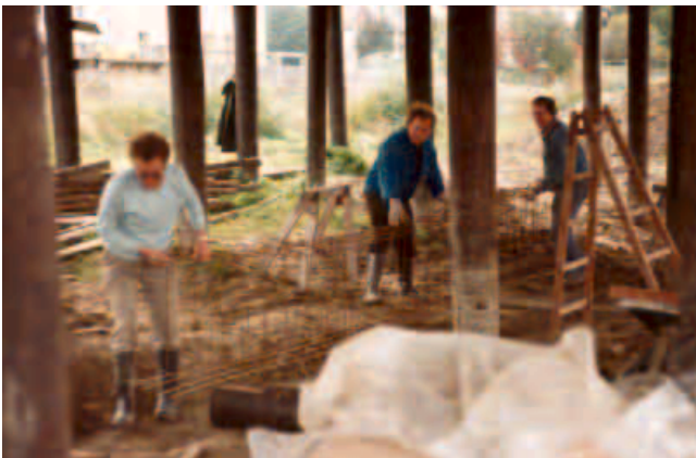
Einbau des Fundaments
